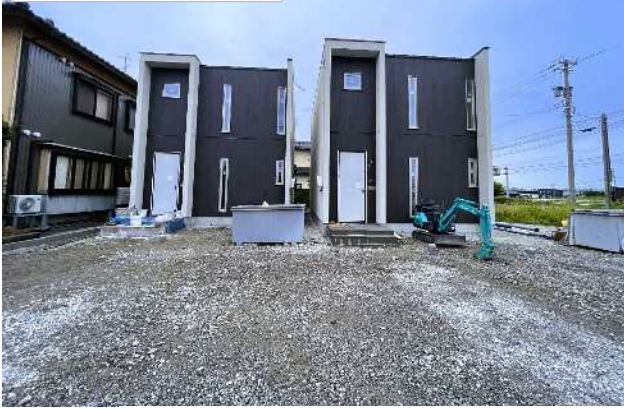
工事中の外観
